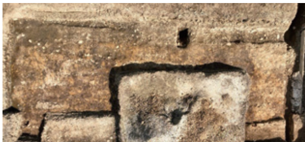
トレンチ3空撮 (直上から)
